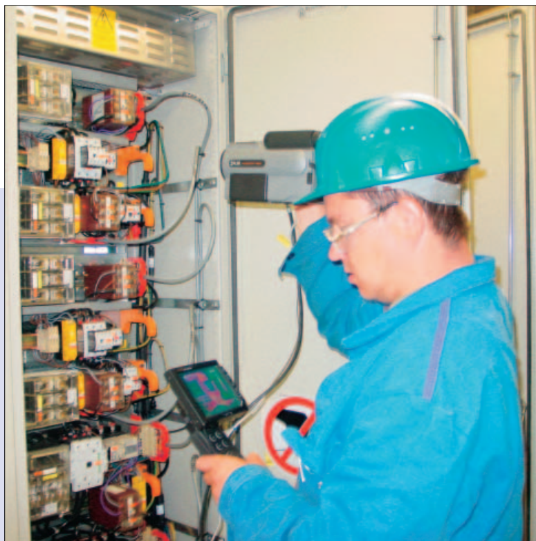
Bild 1: Thermografische Inspektion von Niederspannungsschalt-schränken mit einem getrennten System
