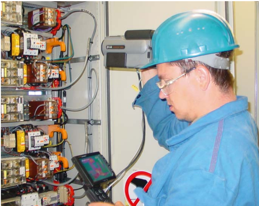
Von VdS Schadenverhütung empfohlen: Thermografiemessung mit einem getrennten System aus Bilddetektor und Bedien-Anzeige-Einheit, das die Inspektion auch von nicht direkt sichtbaren Teilen ermöglicht.
