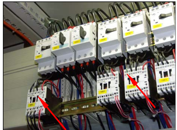
Mit einer billigen Infrarotkamera wären diese zu heißen Anschlüsse mit den kleinen Kabelquerschnitten mit großer Wahrscheinlichkeit unerkannt geblieben
